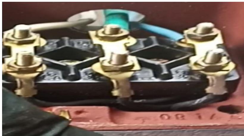
Figura 7 Placa de bornes
