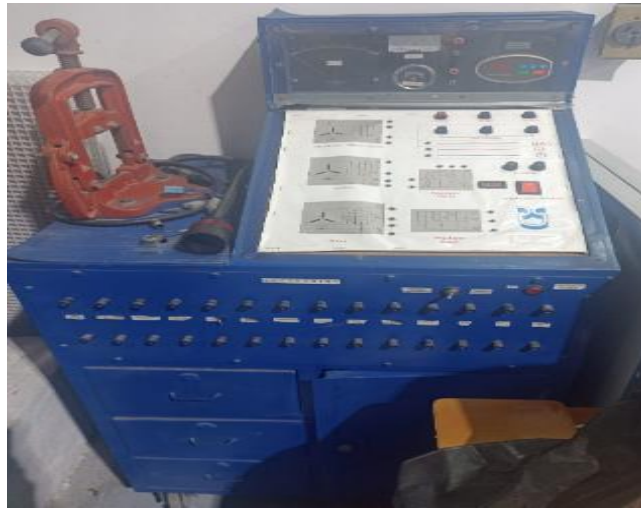
Figura 13 Estructura de bancos de alternadores
