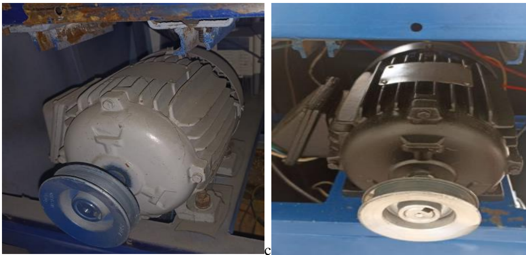
Figura 20 Proceso de reparación del motor trifásico (antes y después)
