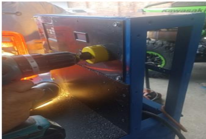
Figura 23 Proceso de instalación de accesorios
