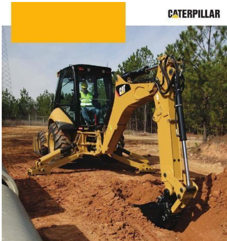
Imagen 209 Retroexcavadora utilizada en la excavación del terreno. Fuente: Caterpillar
