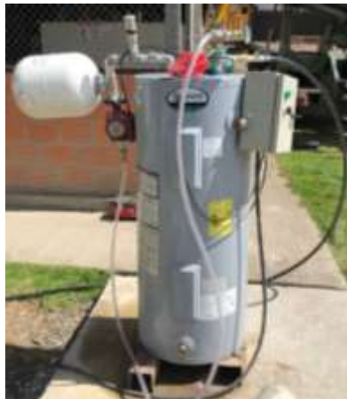
Figura 4. Instalación del equipo para el método de curado
