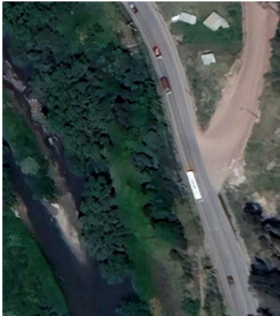
Figura 4-1 Zona donde se ubicará la planta de tratamiento residual.
