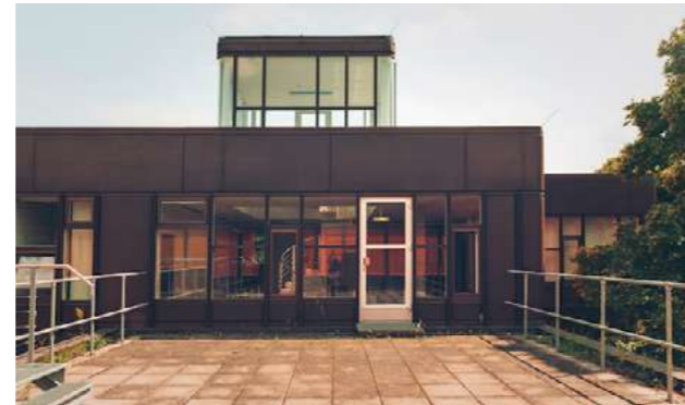
Fig. 60. Vista de un balcón de un edificio
