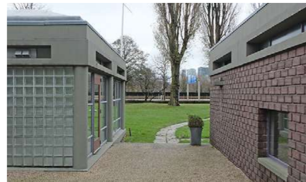
Fig. 67. Vista del edificio al exterior
