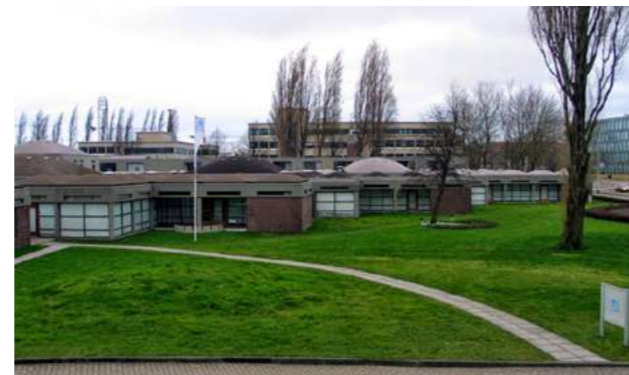
Fig. 66. Vista del exterior al edificio
