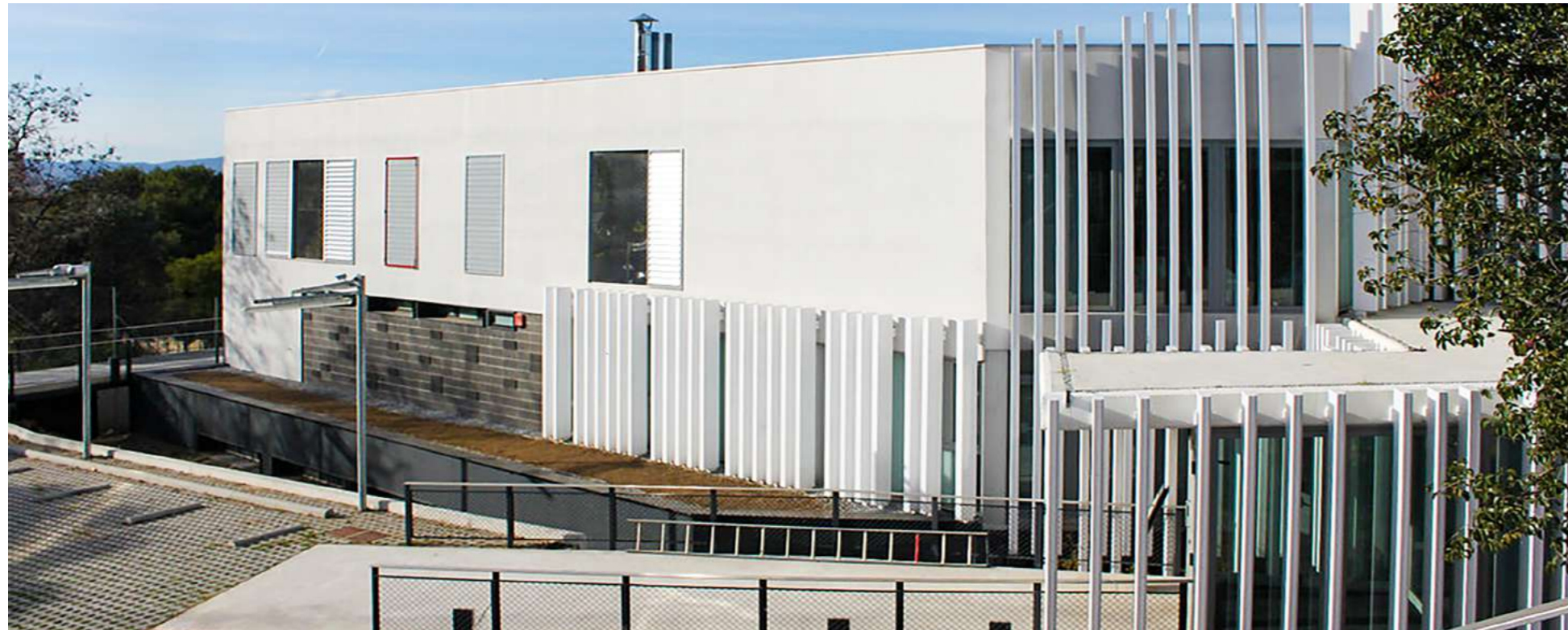
Fig. 28. Vista del acceso principal a la Residencia y Centro de Día para Discapacitados Intelectuales con trastorno de conducta
