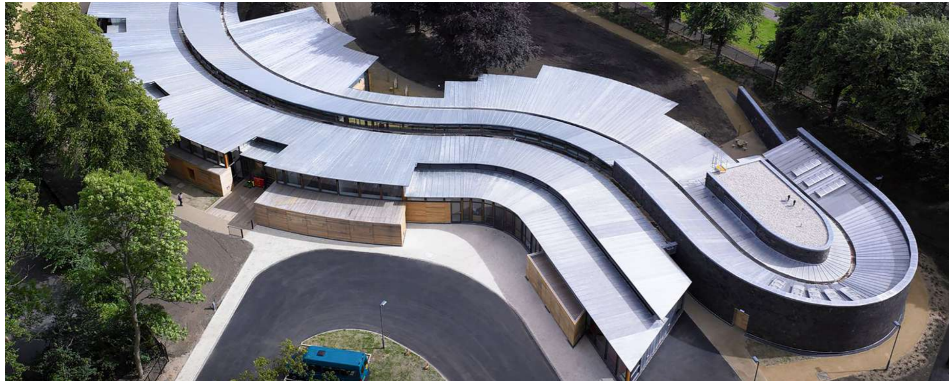
Fig. 50. Vista del acceso principal de la Escuela Hazelwood
