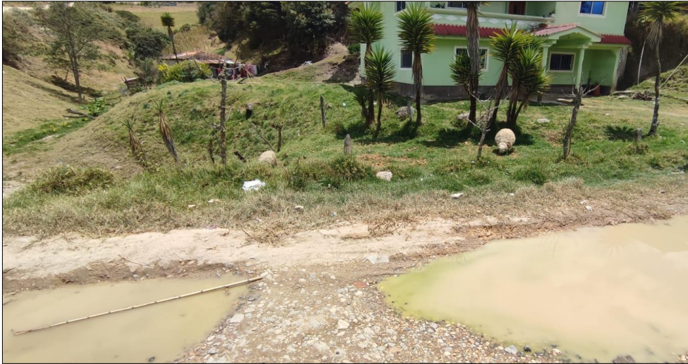
Ilustración 1.8 Estancamiento de aguas residuales.
