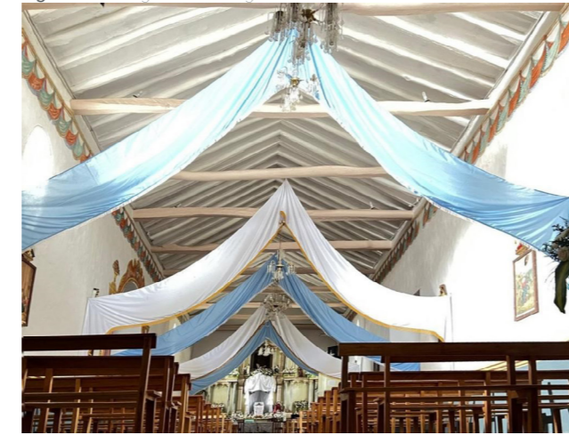
Figura. 18. Fotografía interna Iglesia de Susudel.
