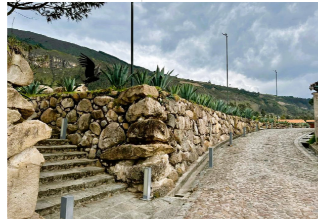
Figura. 73. Fotografía muro de piedra.
