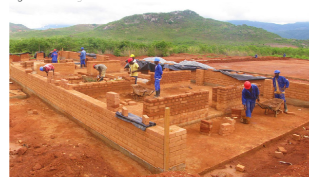
Figura. 37. Fotografía Centro comunitario de Manica.
