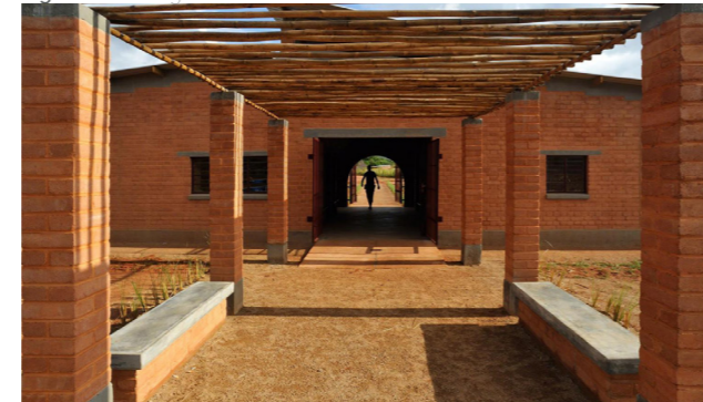
Figura. 38. Fotografía Centro comunitario de Manica.
