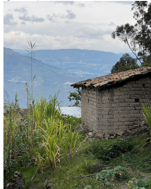
Figura. 72. Fotografía casa de adobe.
