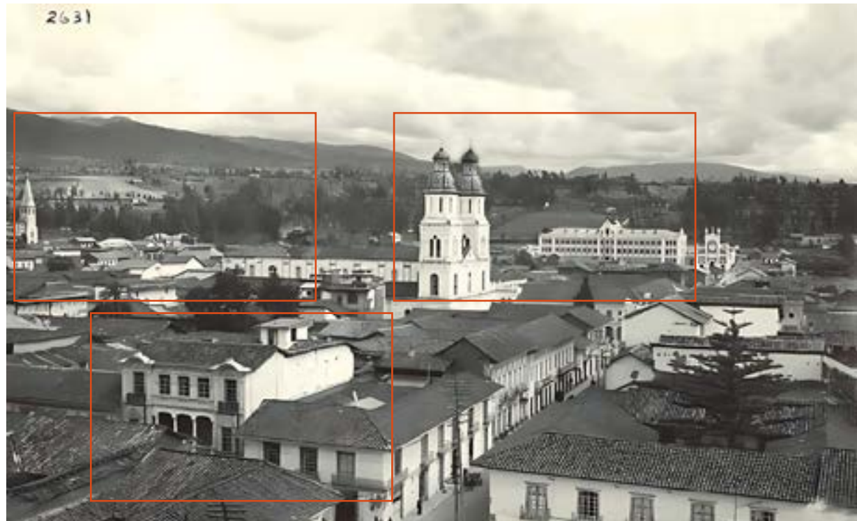
Fig. 61 Vista panorámica de Cuenca, 1935. Fuente: AFH 2631
