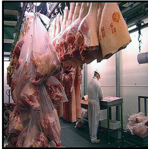
Figura 39: Cámaras de refrigeración
