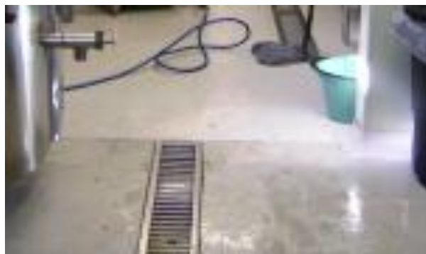
Figura 8. Piso con recubrimiento de poliuretano
