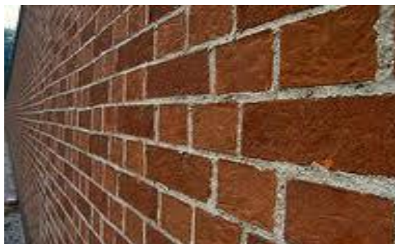
Figura 10. Segmento de una pared de ladrillo.
