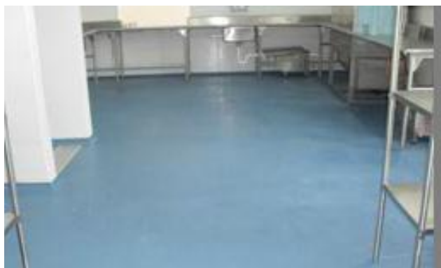
Figura 9. Piso con recubrimiento poliméricos
