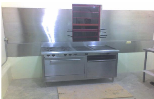
Figura 12. Pared recubierta con láminas de acero inoxidable
