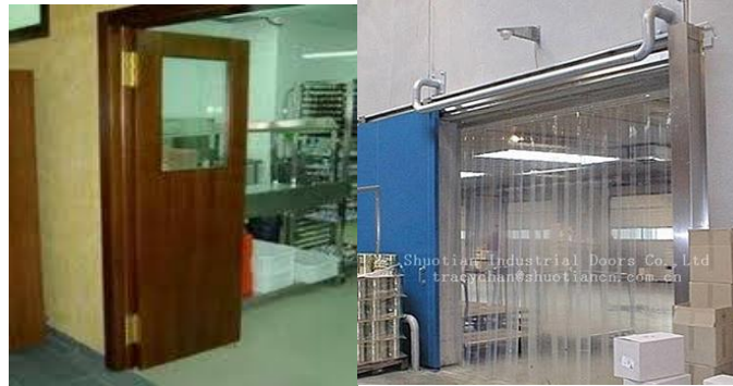
Figura 17. Puerta Vaivén y Cortinas plásticas
