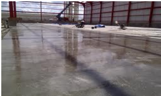
Figura 6. Piso de concreto pulido
