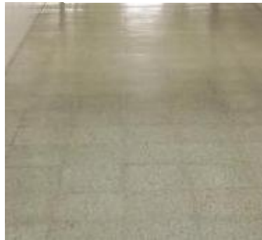
Figura 20 Piso baldosa de vinilo
