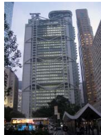
La Sede central del HSBC (Hong Kong) de Norman Foster, es un ejemplo de arquitectura High Tech.
