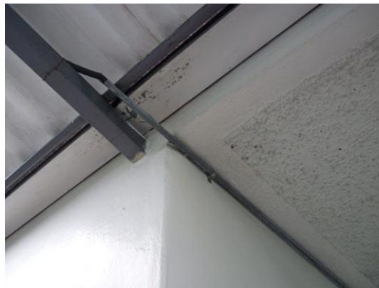
Figura 12 Unión de techo y pared
