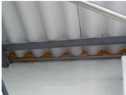
Figura 7 Techo vista interior
