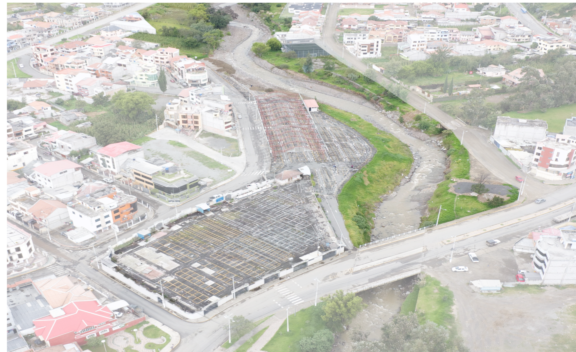
Fig.1. Vista área del sitio del antiguo Mercado Sucre. Fuente: Autor.
