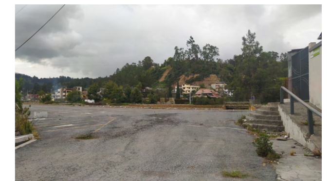
Foto 6. Entrada al segundo bloque en mal estado. Fuente: Autor.
