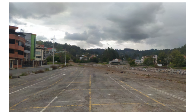
Foto 8. Zona donde se ubicaban las naves metálicas. Fuente: Autor.
