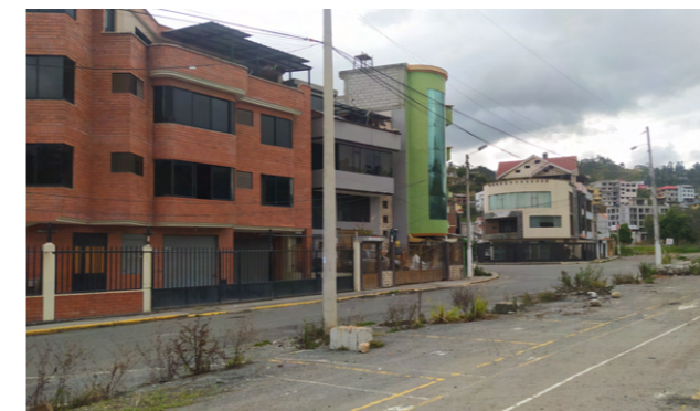
Foto 7. Edificaciones cerradas y abandonadas. Fuente: Autor.
