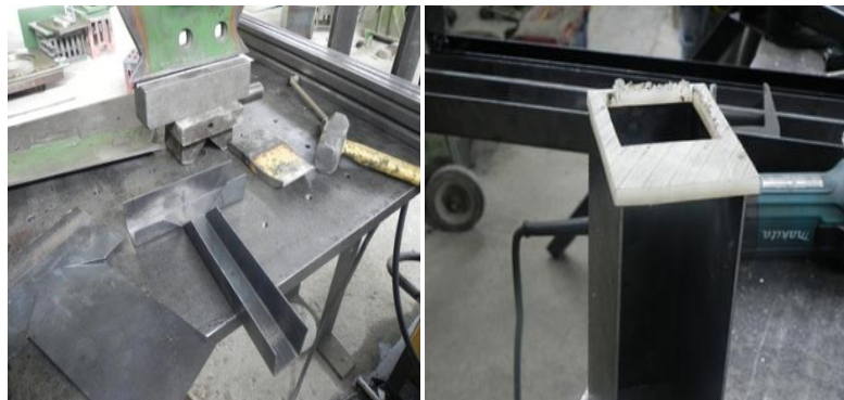
Figura 2.6: Fabricación del sistema de desplazamiento vertical
