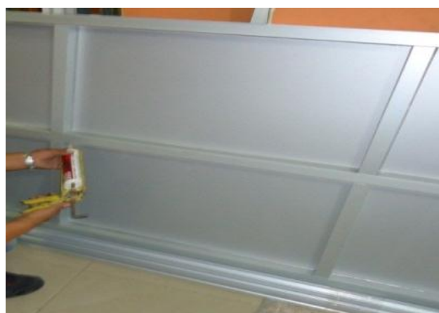
Figura 3.13: Compactación del marco posterior
