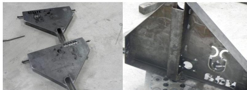
Figura 2.4: Construcción de las bases
