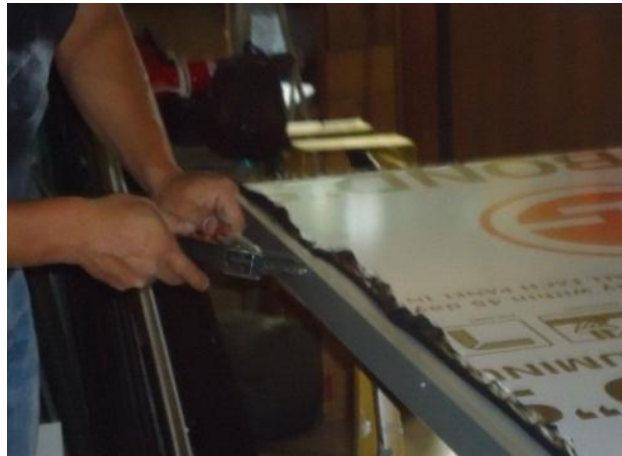
Figura 3.14: Colocación del perfil de aluminio
