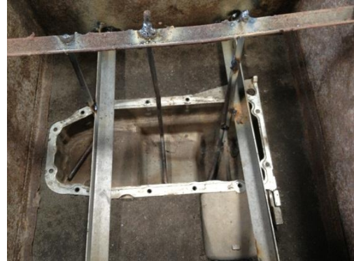
Figura 3.16 Colocación de varillas.
