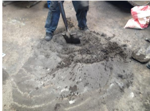
Figura 3. 9 Mezclado de la arena, bentonita y agua.
