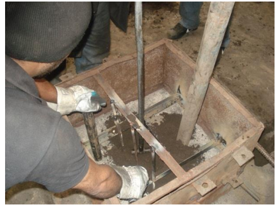
Figura 3.18 Compactación de arena.
