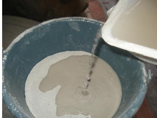
Figura 3. 43 Agua añadida a la mezcla
