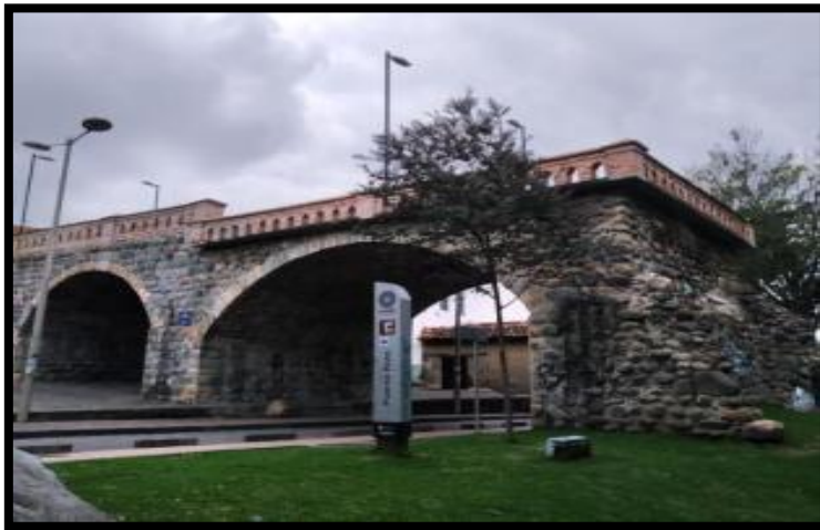
Figura. 32 El Puente Roto
