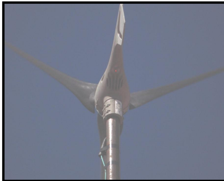
Figura 4.1: Indicador que la turbina está funcionando correctamente.
