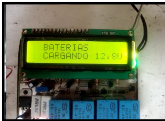
Figura 4.7.7: Cartel que indica la carga de las baterías.
