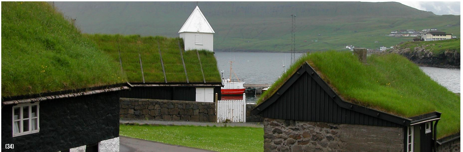
No se refiere a techos ni materiales de color verde. Una cubierta verde o cubierta ajardinada es la cubierta de un edificio que está parcial o totalmente cubierta de vegetación. Estas cubiertas son ecológicas y están destinadas para generar áreas verdes y mejorar el confort acústico y térmico, ahorrando además el consumo de energía por sistemas de climatización.
