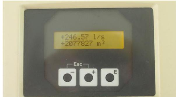
Figura. 4. Medidor de Caudal
