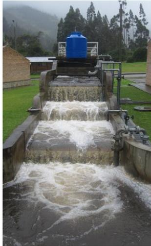
Figura. 5. Cámara de Mezcla Rápida
