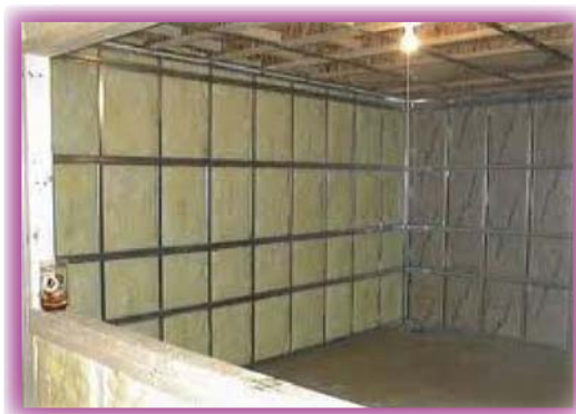
Foto de la construcción de un estudio en progreso. Las paredes son "rellenadas" de "lana roca".
