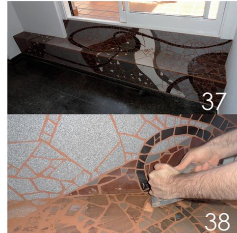
**Método Indirecto:** se dibuja primero una plantilla a medida real sobre la que se encolan las teselas siguiendo la forma del dibujo. El papel con el dibujo tapa, pues, el mosaico del que sólo se puede ver el reverso. Esta operación se realiza
