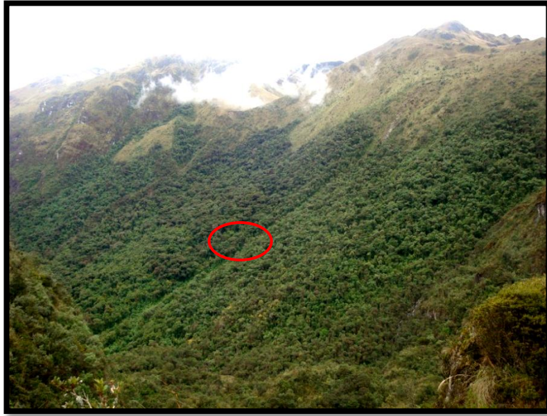
Fotografía 16. Deslizamiento en el Bosque Altoandino (Llaviuco).
