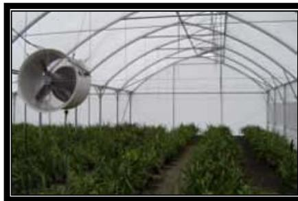
**Figura 2.2.** Ventilación mecánica o forzada
