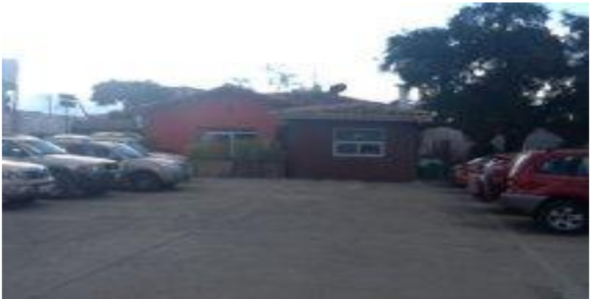
FACHADA INTERIOR DEL PREDIO Y PARQUEADEROS.
