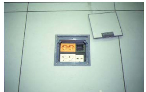
FIG. 38 TUBERÍA BAJO EL PISO
