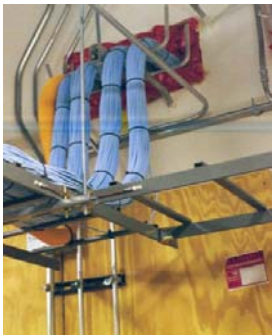
FIG. 41 FOTOS DE ESCALERAS PORTA CABLES www.images.google.es
