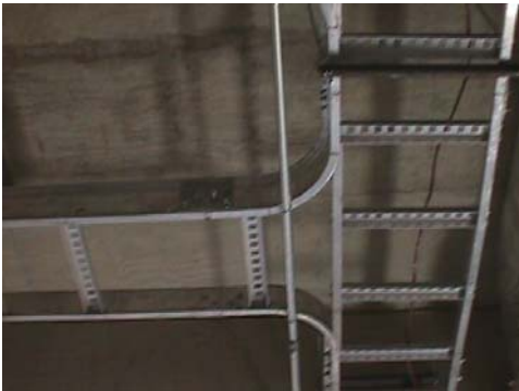
FIG. 41 FOTOS DE ESCALERAS PORTA CABLES www.images.google.es
