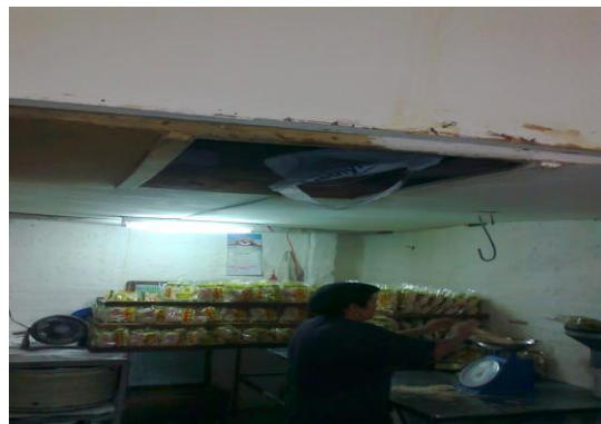
Figura 3.- Paredes y techos
