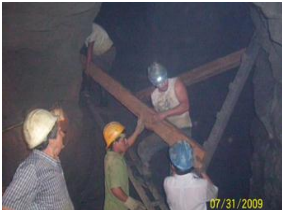
Figura N.- 28 Construcción de buzones para el carguío de material Fuente archivos de la empresa
