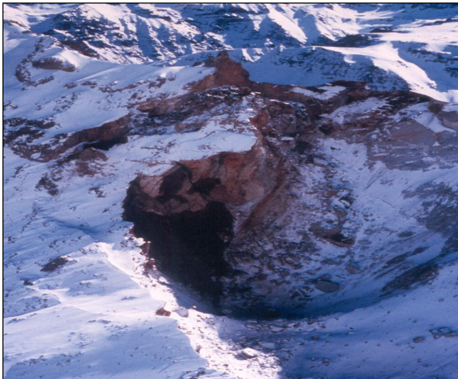
Figura N° 27 - Zona de colapso en superficie (mina de cobre El Teniente, Chile), provocada por el hundimiento de bloques en profundidad. Fuente: Oyarzun R. Sistemas de explotación, 2005
