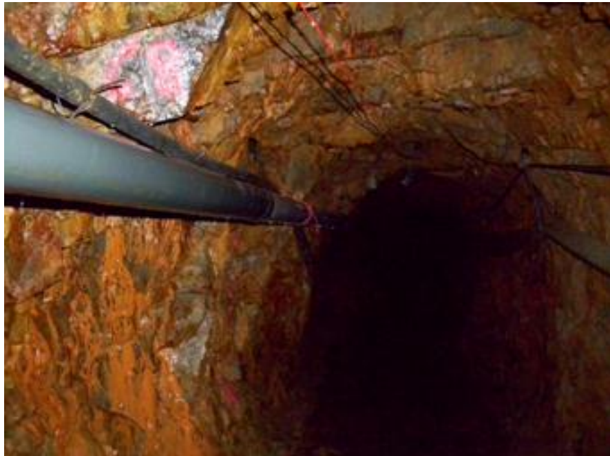
Foto N.- 14 tubería utilizada dentro de la mina. Fuente: archivo de la empresa
