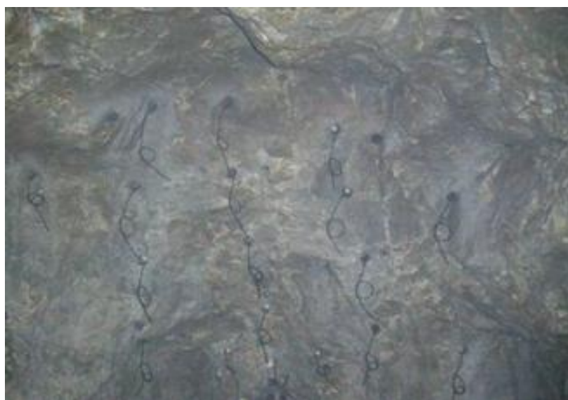
Figura N.- 13 Trabajo de un frente perforado en cuña (BLOQUE 1) Fuente: Archivo de la empresa
