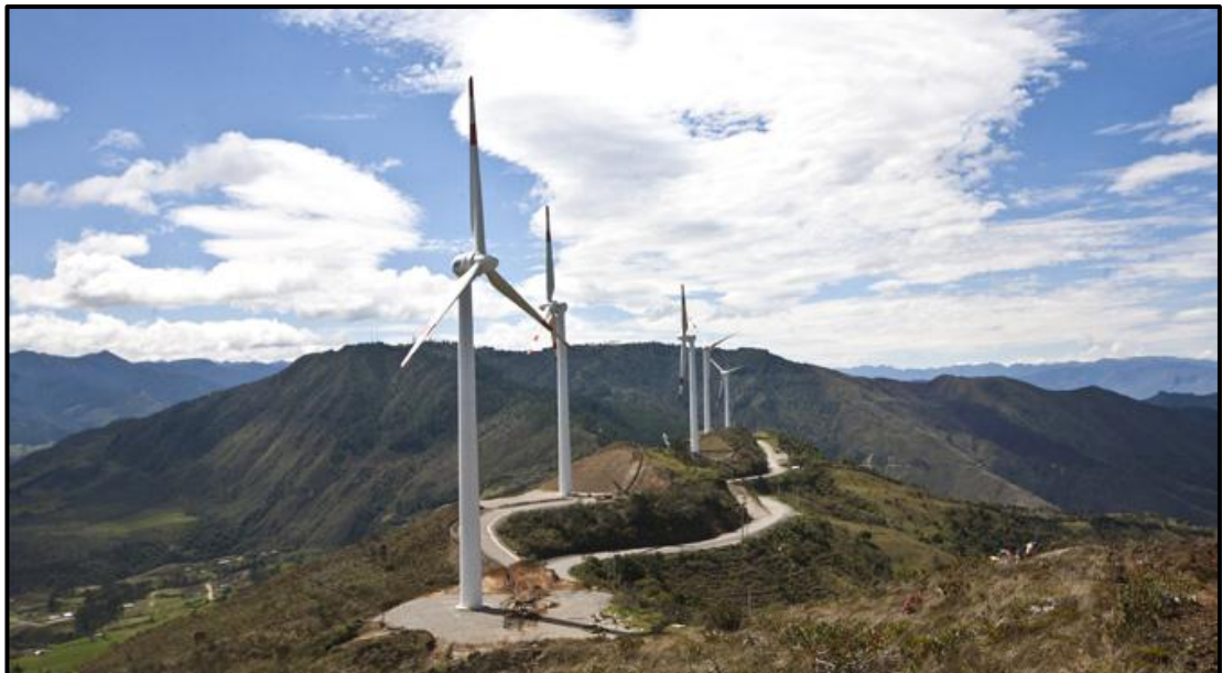
Figura 2.7 Parque Eólico Villonaco. (Ministerio de Electricidad y Energía Renovable. Galería)
