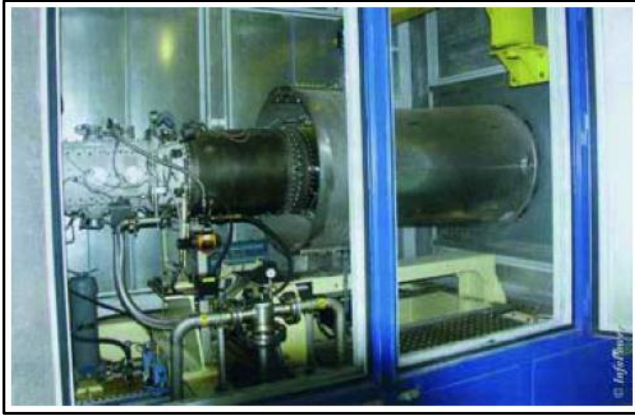
Figura 2.2 Turbina de gas de 3,8 MW. (FENERCOM. Guía Básica de la Generación Distribuida, Pág. 15)
