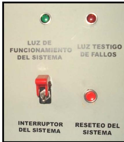
Figura 3.21. Interruptores panel del control.
