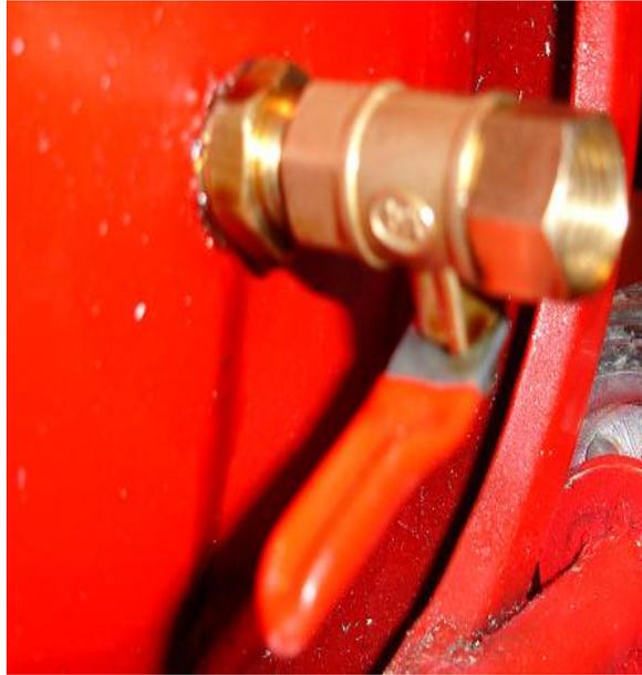
Figura 3.42 Instalación de la llave de descarga.
