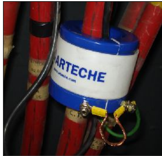
Fotografía 1.5: Imagen Real Acoplador Inductivo
