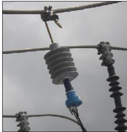
Fotografía 1.4: Imagen Real Acoplador Capacitivo
