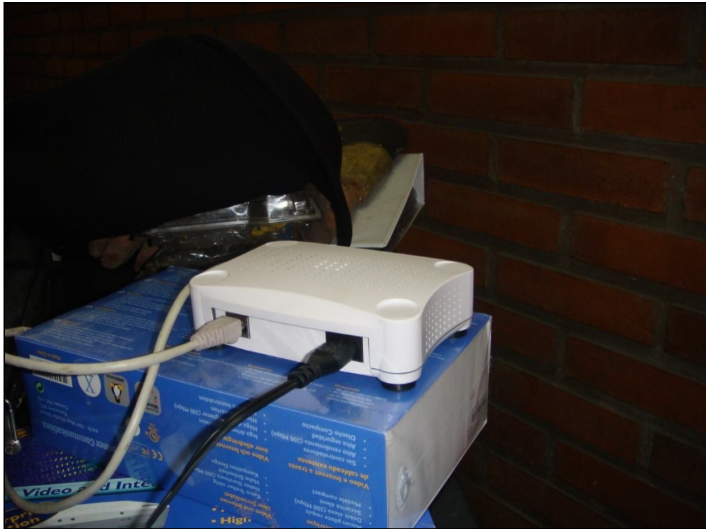
Fotografía 3.3: Conexión del módem a la toma de corriente eléctrica que ya cuenta con el servicio de PLC.
