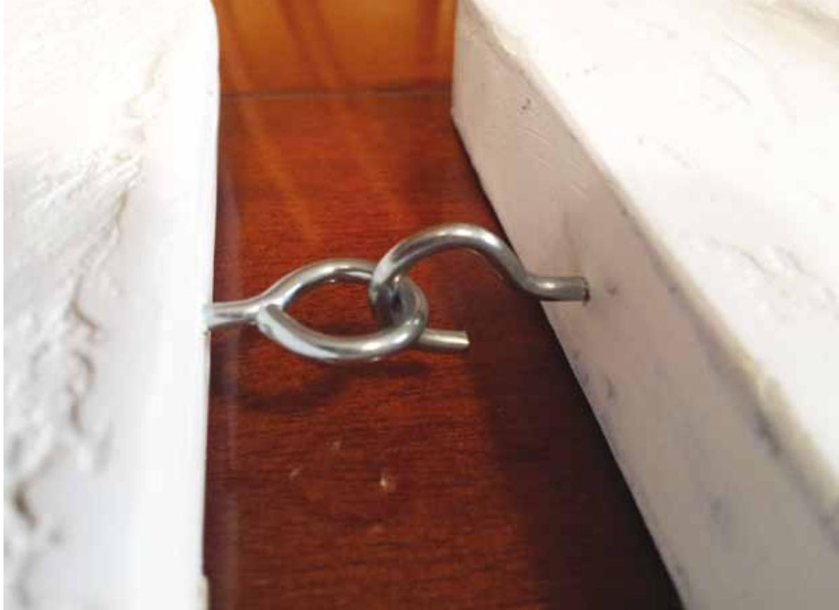
**IMAGEN 59** - DETALLE DE UNIÓN CON CÁNCAMOS
