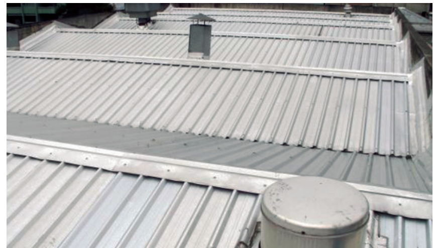
F 53. Revestimientos con láminas metálicas en techo.
