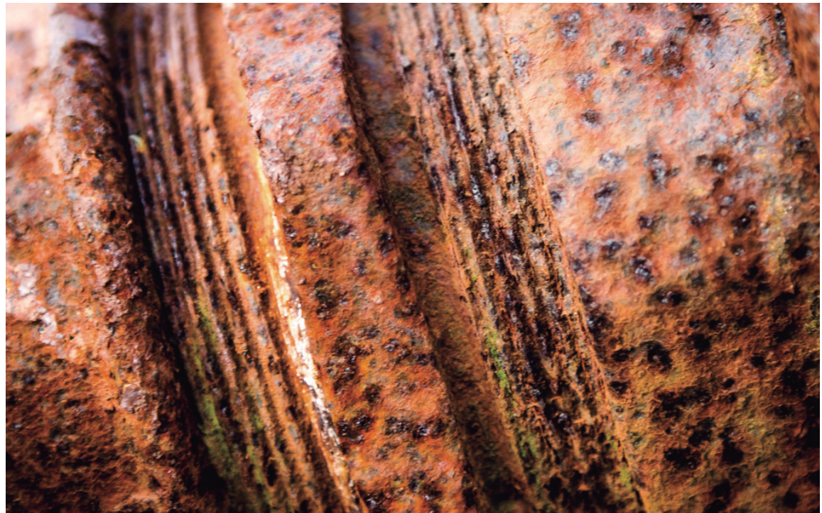
F 15. Metal oxidado
