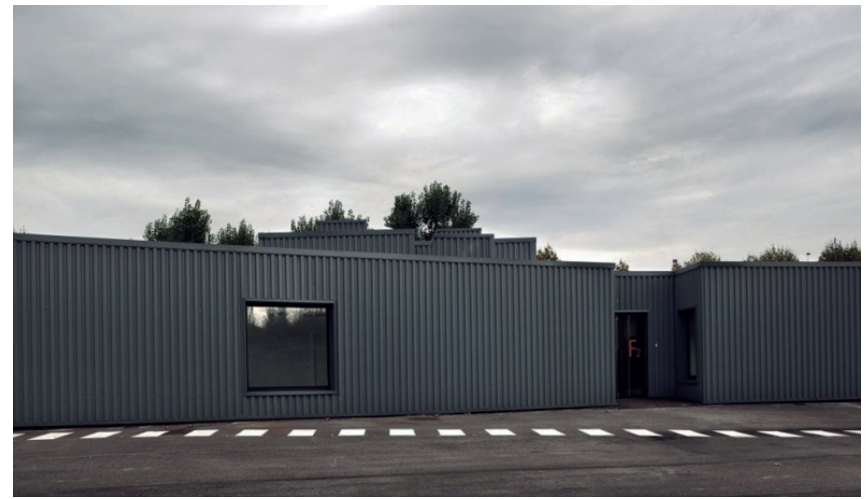
F 52. Revestimientos con láminas metálicas en fachada.
