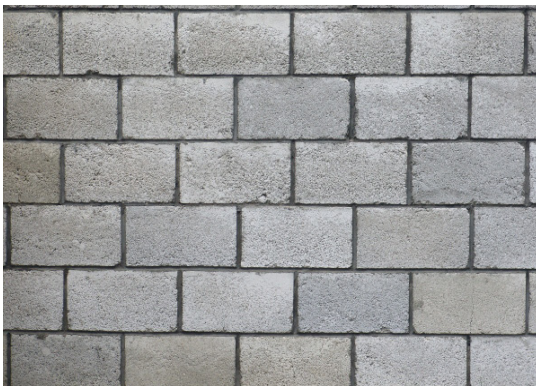
Imagen 60: Muro de bloque.
