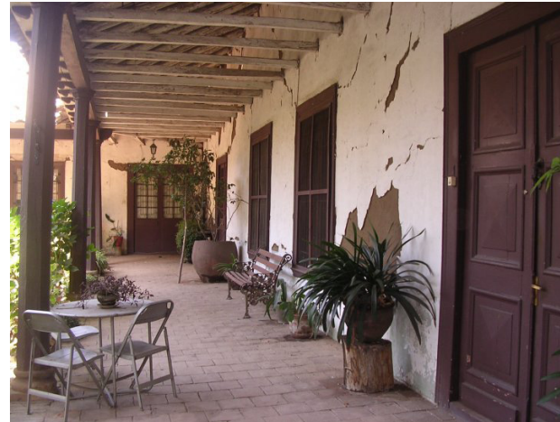
Imagen 69: Construcción con adobe.
