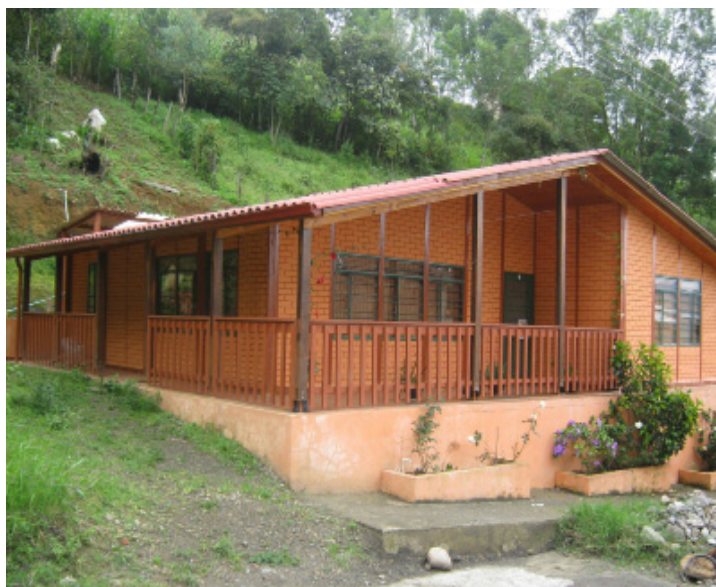
Imagen 68: Vivienda de ladrillo.
