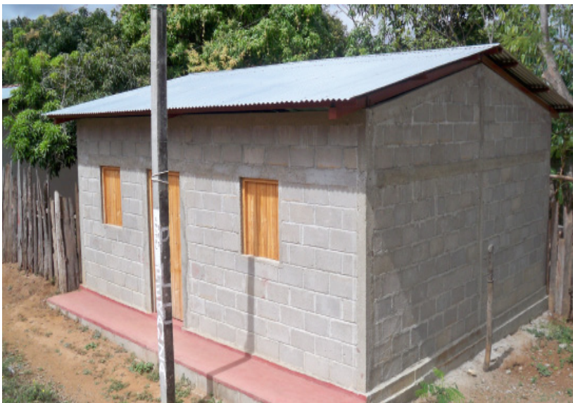
Imagen 61: Vivienda de Bloque
