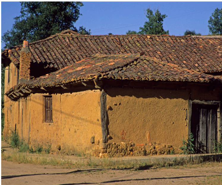
Imagen 70: Vivienda de adobe.
