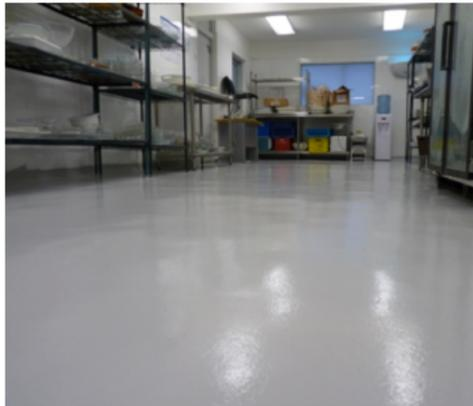
Foto 33. Piso Epóxico preparación
