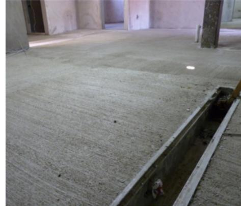
Foto 35. Piso Concreto con desagües
