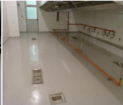
Foto 34. Piso Epóxico cocción
