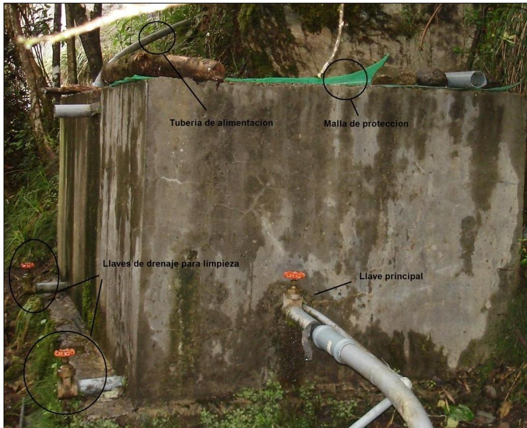
**Figura #40.** Tanque de sedimentación.
