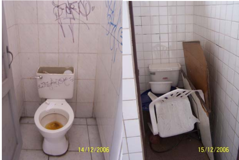
Inodoros: Colegio Benigno Malo y Escuela Ivan Salgado
