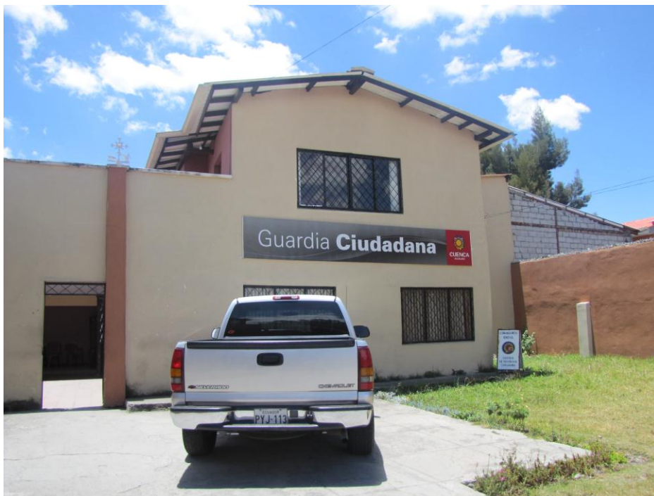
Fotografía # 2 Exterior de la Casa de la Guardia de Seguridad Ciudadana de Cuenca.
