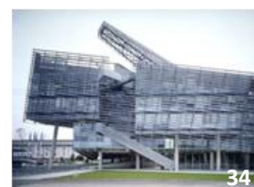
34. Hypo Bank (2002) Arquitecto: Thom Mayne
