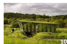
Mimetic House (2005) Arquitecto: Dominic Stevens
