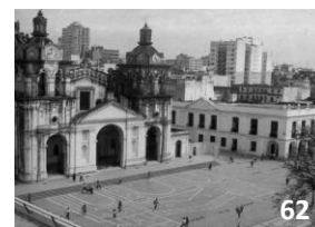
Plaza de Armas (1980) Arquitecto: Miguel Angel Roca
