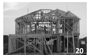
Sistema Constructivo denominado Balloon Frame.
