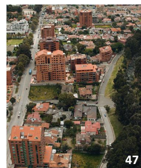
Zona residencial de edificios multifamiliares. Cuenca/Ecuador
