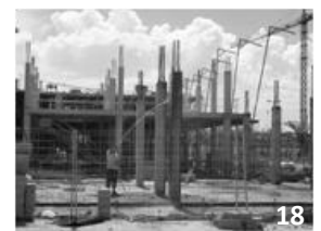
Estructura de Hormigón Armado.
