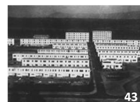
Barrio Dammerstock (1927) Arquitecto: Walter Gropius
