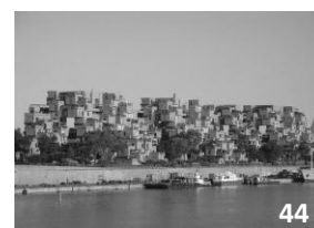
Habitat 67 (1967) Arquitecto: Moshe Safdie
