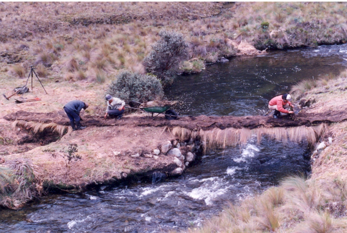
Fotografía 4: Soportes de un puente Inca sobre el río Osohuaycu. Fotografía tomada por el grupo de investigación del Proyecto Qhapaq Ñan
