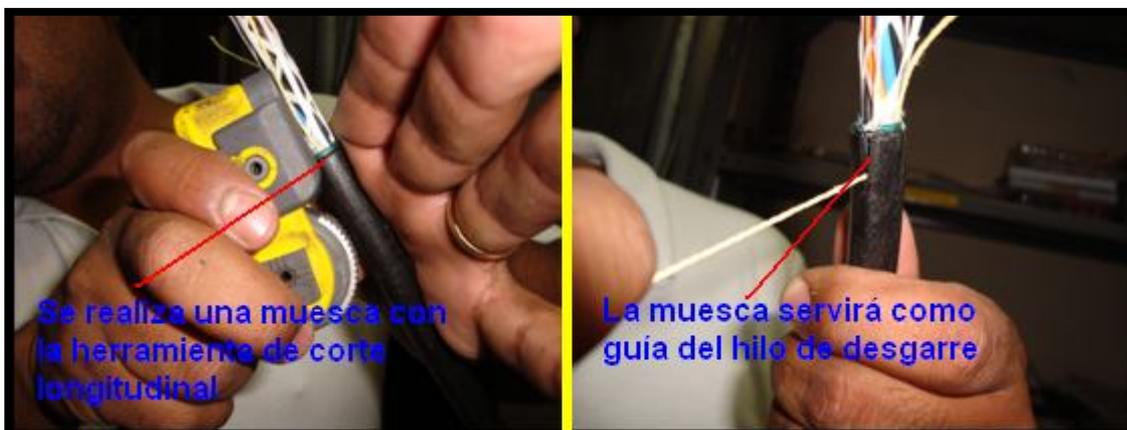
Figura A1.7. Utilización de los hilos de desgarre.
