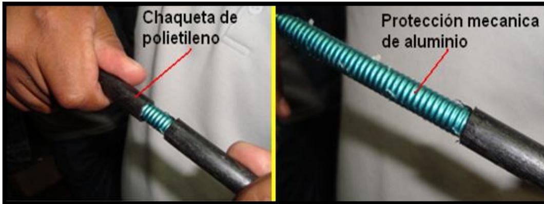
Figura A1.5. Estado inicial de la preparación del cable.
