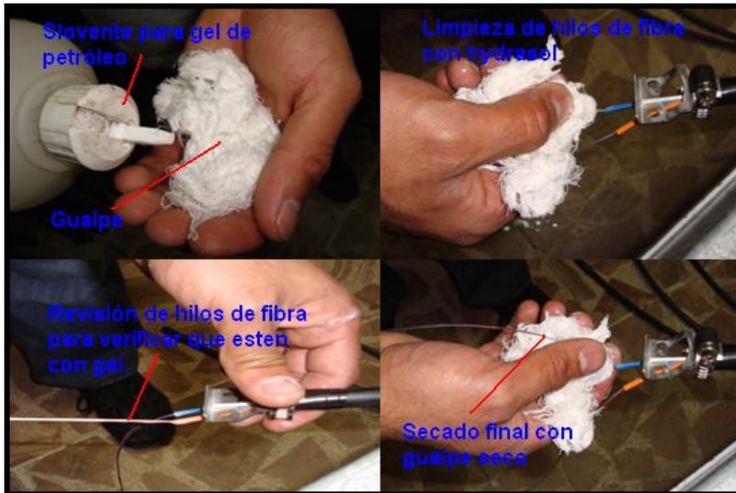
Figura A1.13. Limpieza con HydraSol de los hilos de fibra óptica y respectivo secado.
