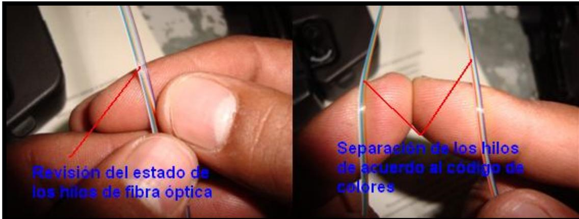
Figura A1.15. Sujeción final del cable de fibra y ordenamiento de los hilos.
