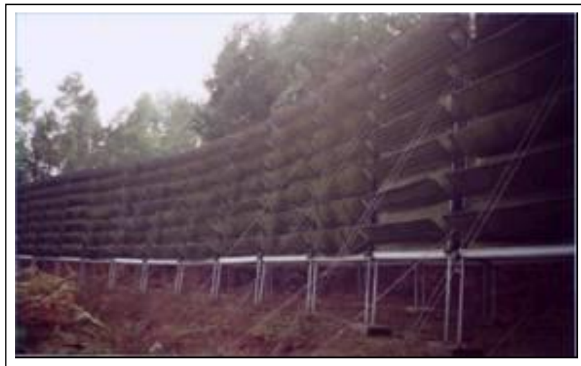
Figura #28: Varias unidades de captación colocadas una junto a la otra
