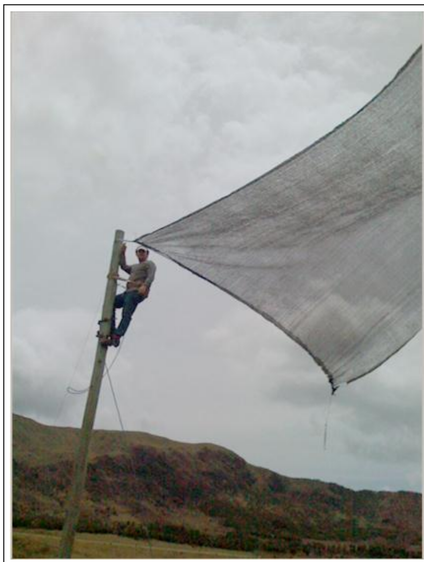
Figura #104: Montaje de la malla en los postes.
