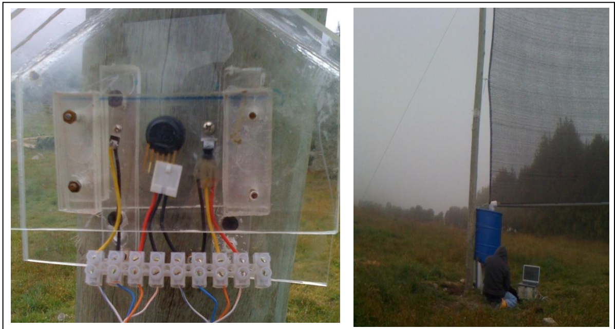
Figura #123: Montaje de los sensores de presión, temperatura y humedad.
