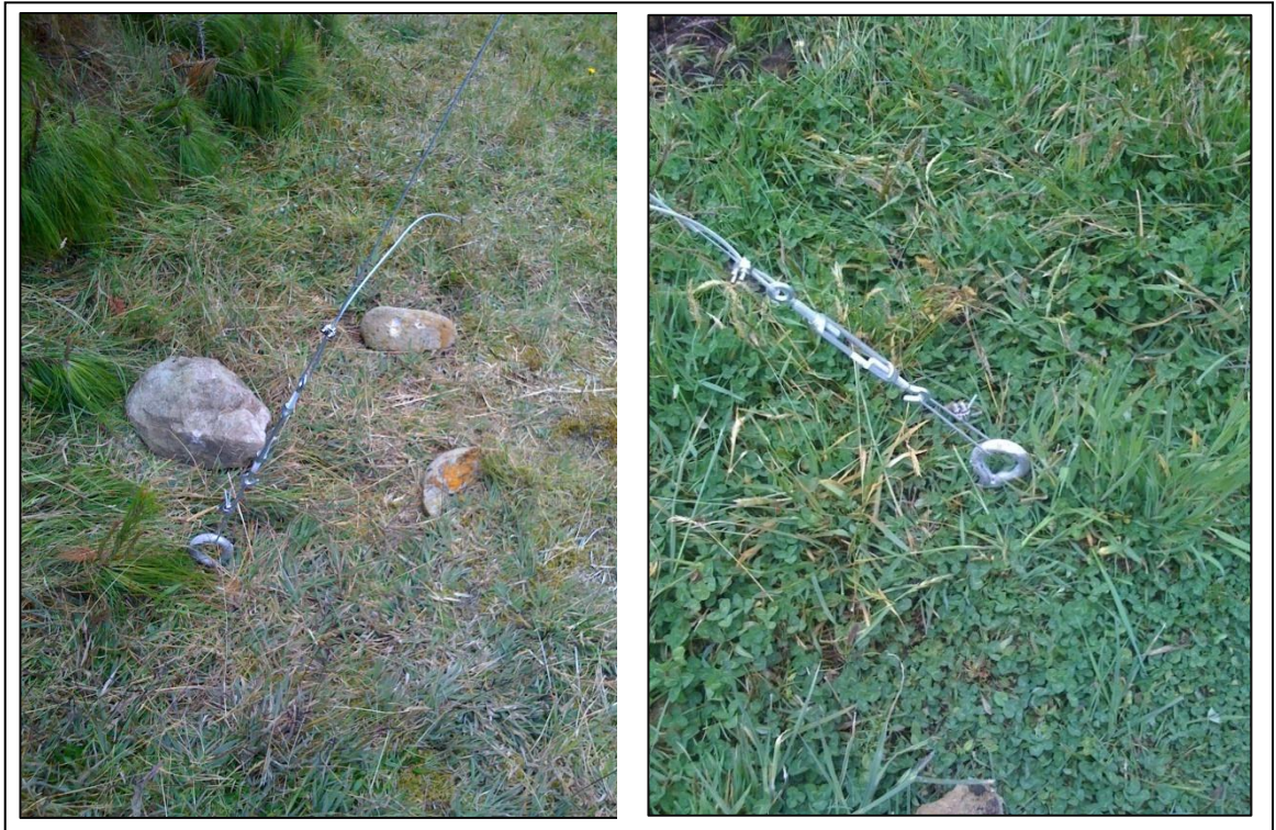
Figura #100: Tensor del poste al piso en una varilla de anclaje.
