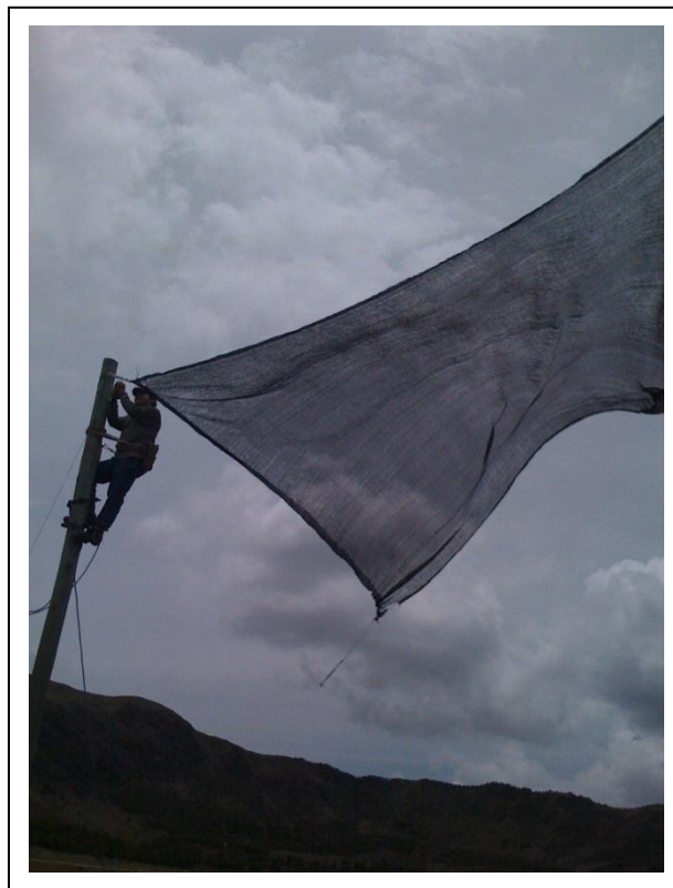
Figura #97: Montaje de la malla piloto.
