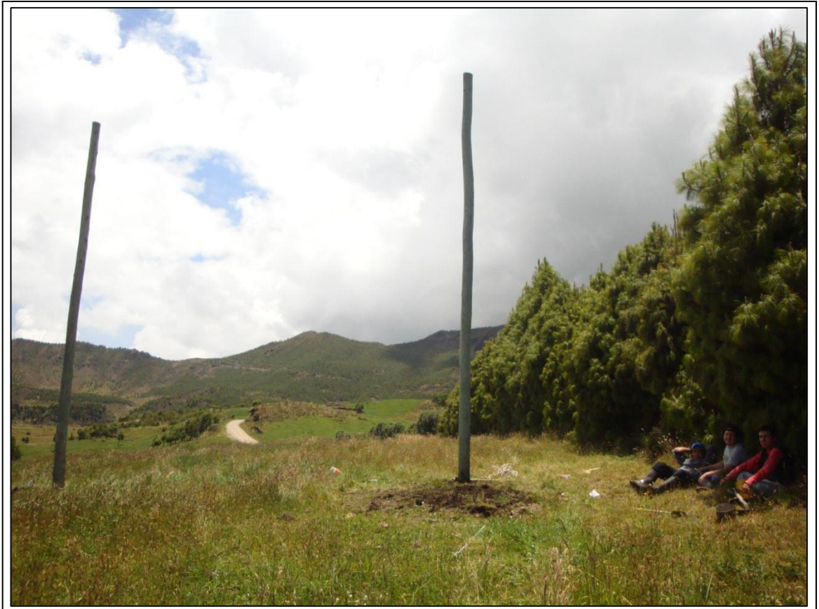
Figura #99: Levantamiento de los postes de soporte.
