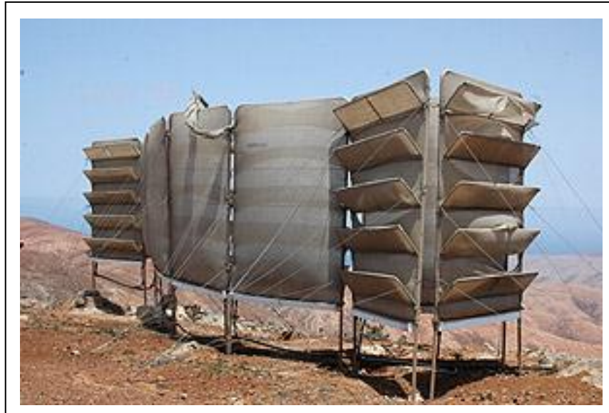
Figura #18: Ilustración de la disposición de los soportes y tensores en un módulo múltiple
