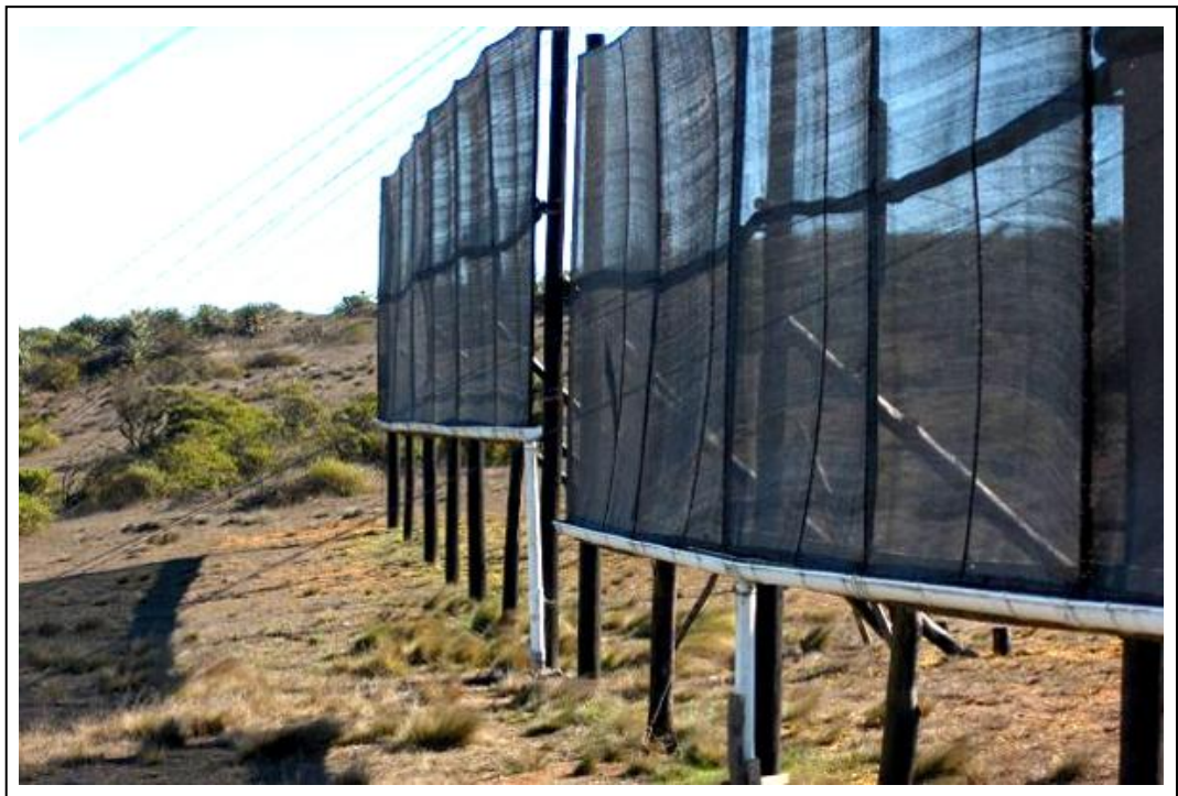
Figura #16: Módulos de captación en disposición lateral
