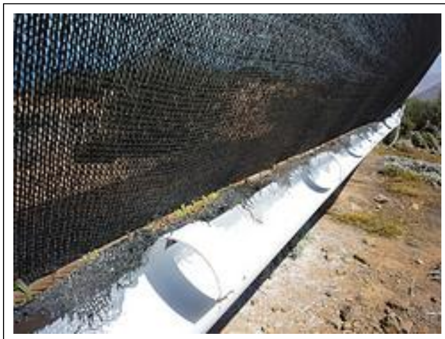
Figura #19: Sujeción de la canal de conducción de agua en la malla
