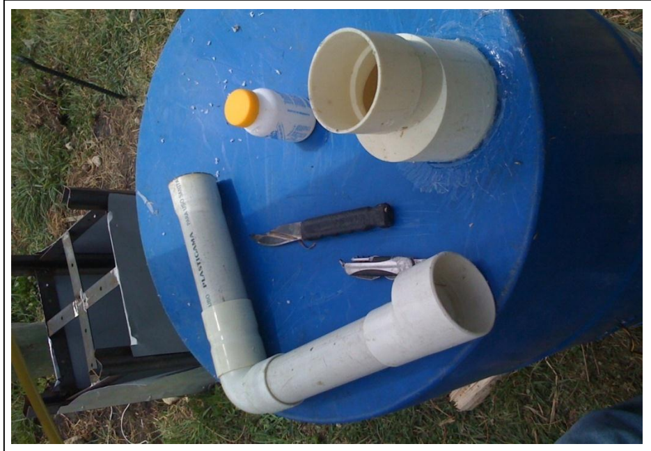
Figura #108: Desfogue en el tanque de almacenamiento y estructura de soporte del tanque.
