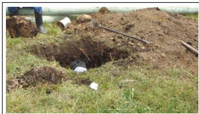
Figura #62: Excavación para fijar los postes
