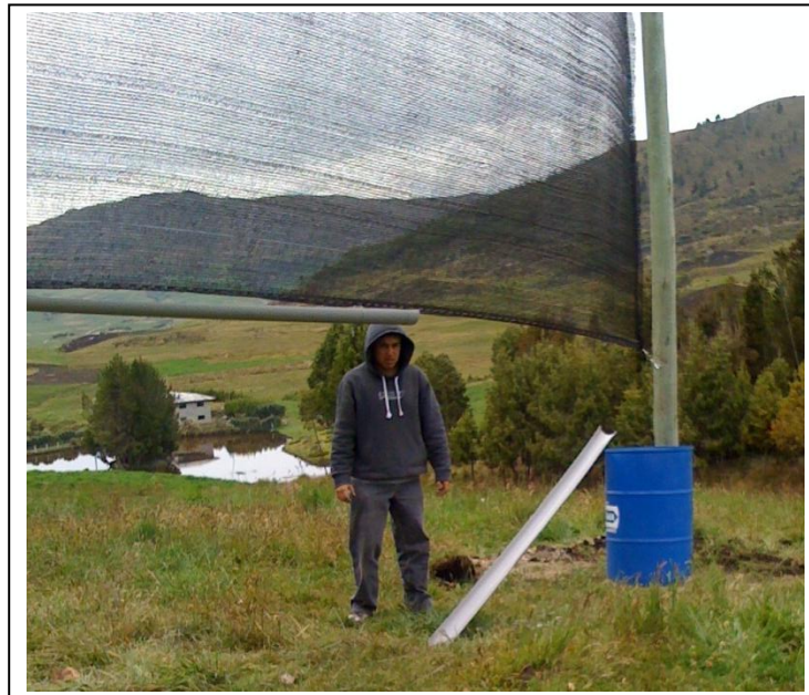
Figura #106: Montaje de la canal de recolección.
