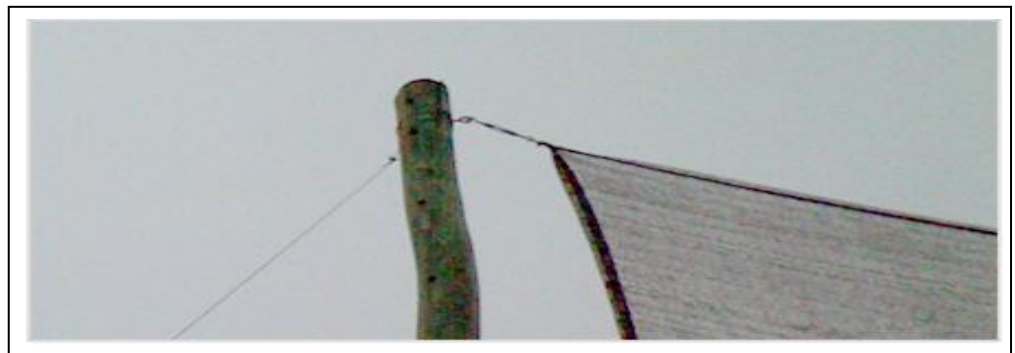
Figura # 102: Tensor mecánico superior.
