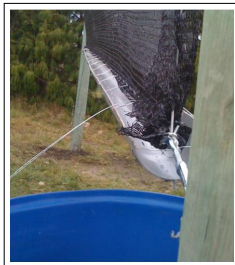
Figura #107: Canal de recolección sujeta a la malla.
