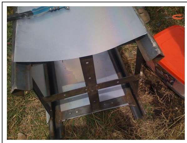
Figura #109: Construcción de la estructura de soporte del tanque.
