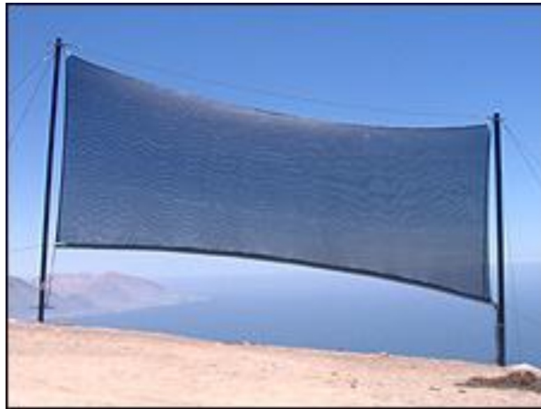
Figura #17: Diseño básico de una malla de captación
