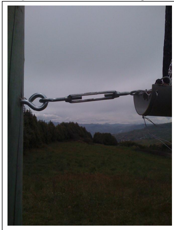
Figura # 102: Tensor mecánico superior.
