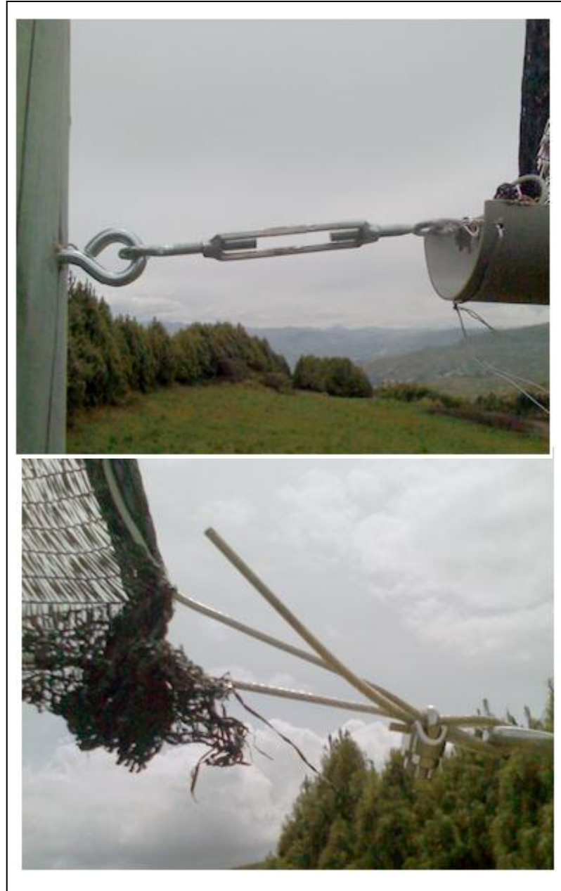
Figura #65: Fijación del marco de acero al poste
