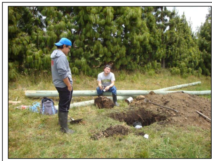
Figura #101: Excavaciones para los postes de sostén.
