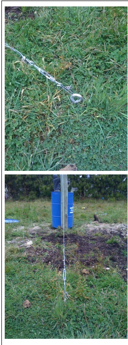
Figura #64: Varilla enterrada en dirección de la malla
