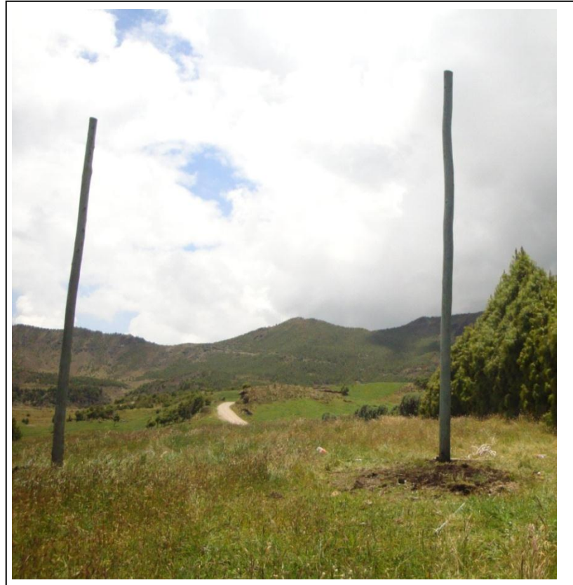
Figura #63: Poste de madera tratada
