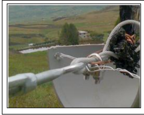
Figura #68: Sujeción de la malla a los tensores
