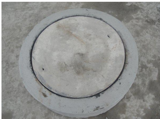
Fotografía de brocal con tapa de 0.60cm de diámetro.
