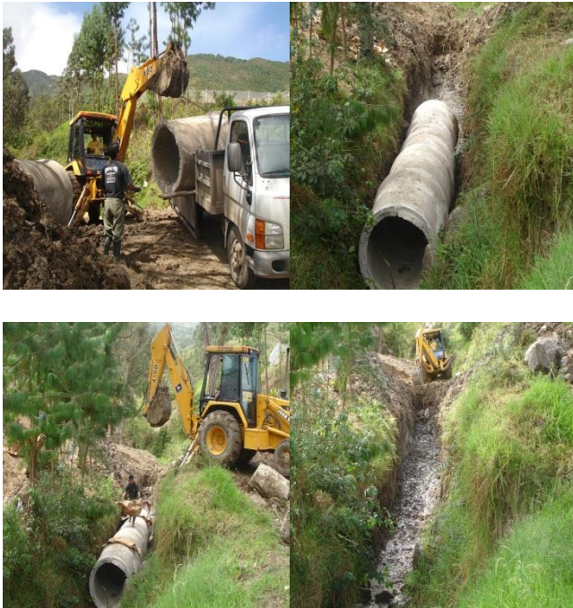
Fotografías de obras de alcantarillado que se realizan en el cantón Cuenca, parroquia Santa Ana.
