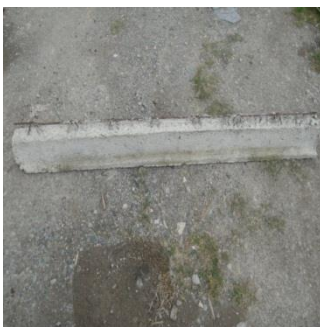
Fotografía de viga las mismas que se fabrican de diferentes dimensiones desde 1m hasta 6m, algunas de las cuales se las utiliza para losas.
