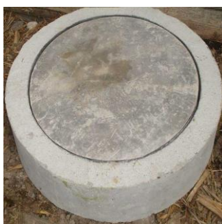
Fotografía de brocal con tapa de 0.70cm de diámetro.
