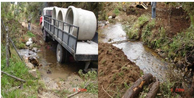
Fotografías de obras de alcantarillado que se realizan en el cantón Gualaceo.
