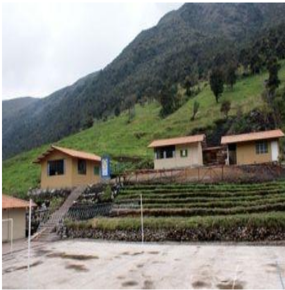
Foto#31 Fuente Club Rotario Tomebamba
