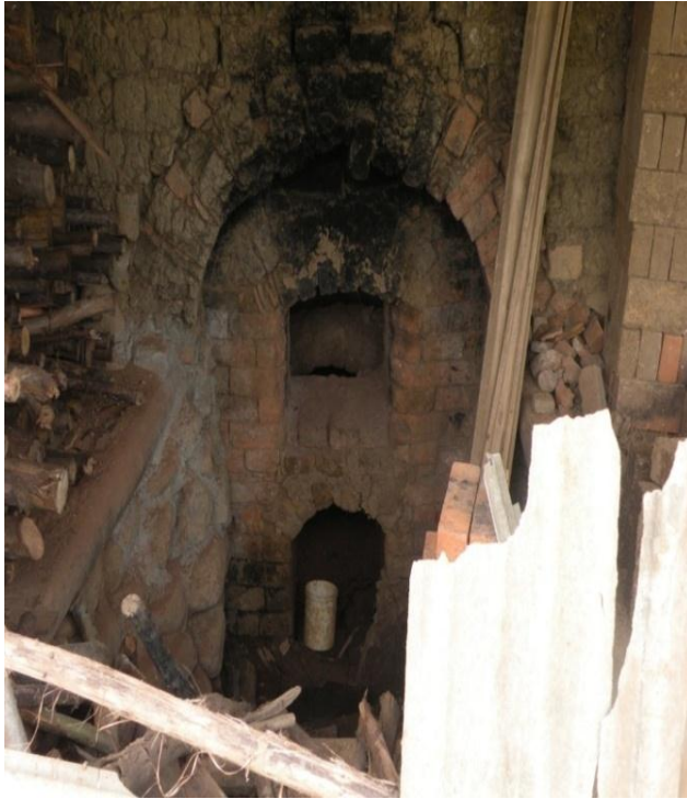
Foto#59 Fabrica de ladrillos Autor: Juan Pacheco
