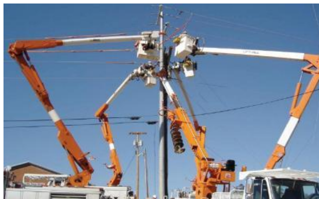
Figura 2.5: Tendido de fibra Aérea.
