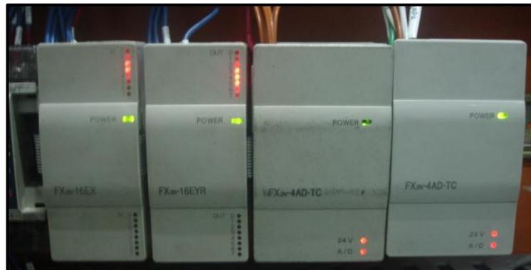
Figura 7.3: Módulos Mitsubishi de expansión de entradas y salidas, Módulos Analógicos de Adquisición de Temperatura.
