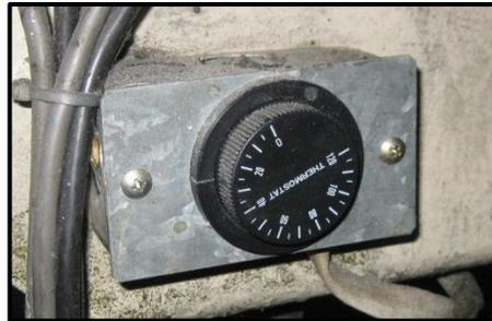
Figura 1.5: Termostato que se utiliza para la medición de temperatura.
