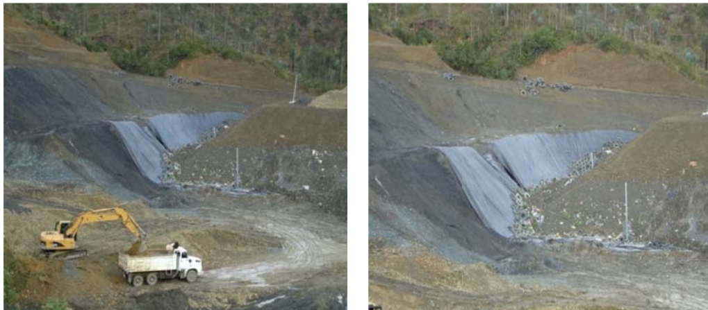
Figura 2. 20 Colocación de las llantas fuera de uso sobre la geo membrana.
