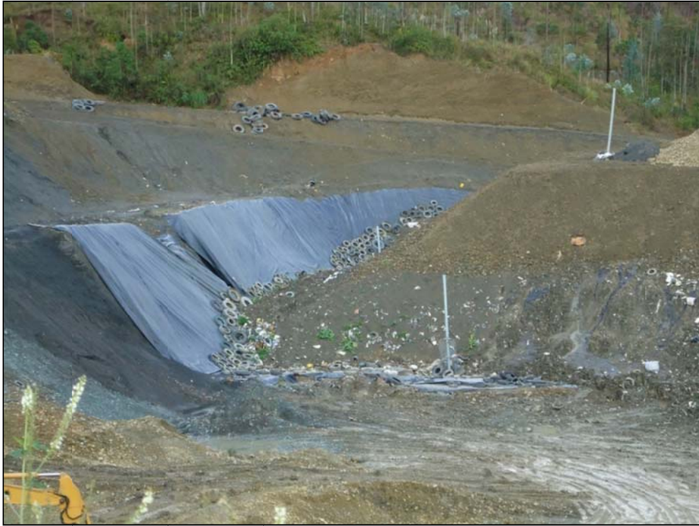
Figura 2. 21 Colocación de las llantas fuera de uso sobre la geo membrana.
