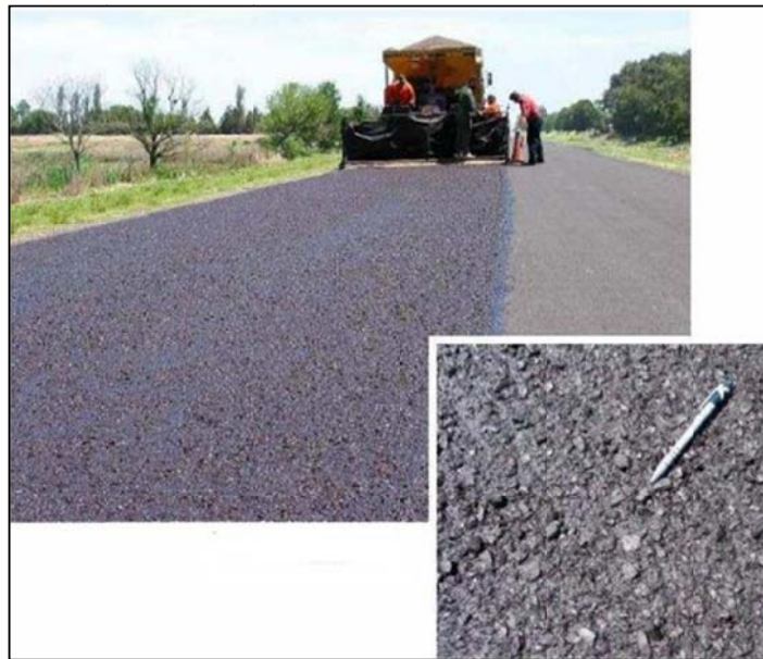
Figura 3.15 Asfalto mezclado con neumáticos.
