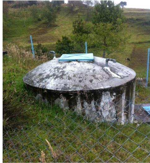
En el caso de Rurcaja el tanque presenta fisuras y no ha tenido mantenimiento en mucho tiempo, la salida del tanque las tuberías y llaves en donde inicia la red de distribución se encuentran oxidadas dando mala calidad del agua antes que empiece la distribución del agua.
