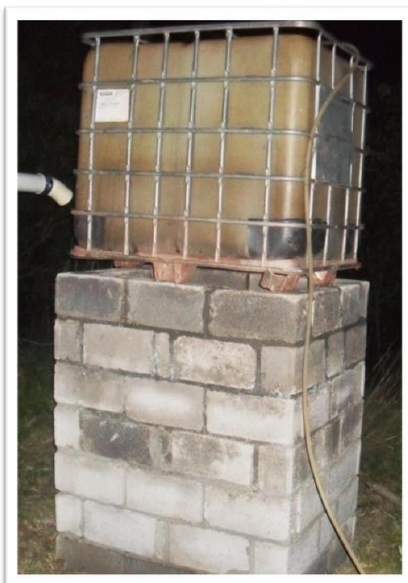
Figura 8 Tanque de abastecimiento conjuntamente con la caja del vertedero que rompe la velocidad del agua
