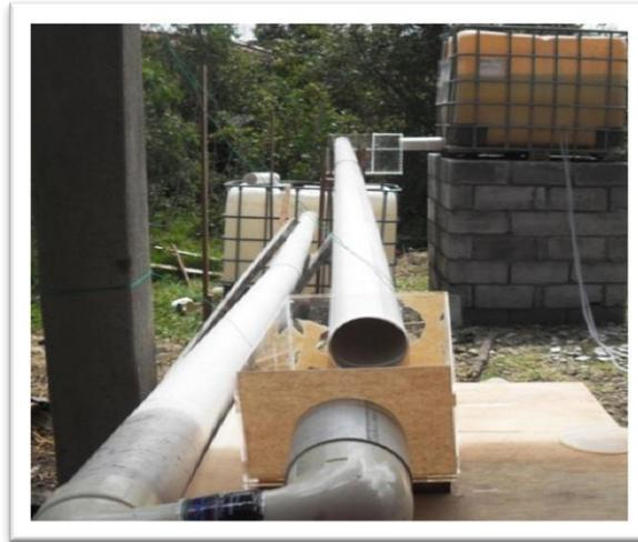
El siguiente paso es el unir el derivador tipo salto a la tubería de conducción, para ello también se realiza una base en la que se pueda sostener el derivador y la cual tenga la altura correspondiente debido a la diferencia de altura entre la entrada y salida de la tubería de conducción por la pendiente dada a la misma (Figura 12 y 13).
